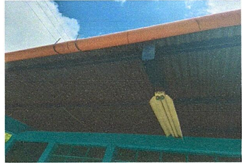
Foto 2: Instalación de canchales para recibir agua de lluvia.
