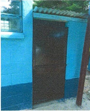
Foto1: Instalación de puerta de baño.
